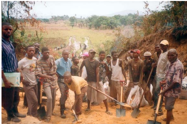
La construction de la Route de Rixensart qui reliera N'Selé à Maluku.
